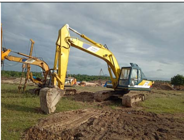
Phát quang mặt bằng, thi công cọc bê tông đổ tại chỗ Clearing ground, constructing concrete cast in-situ piles
