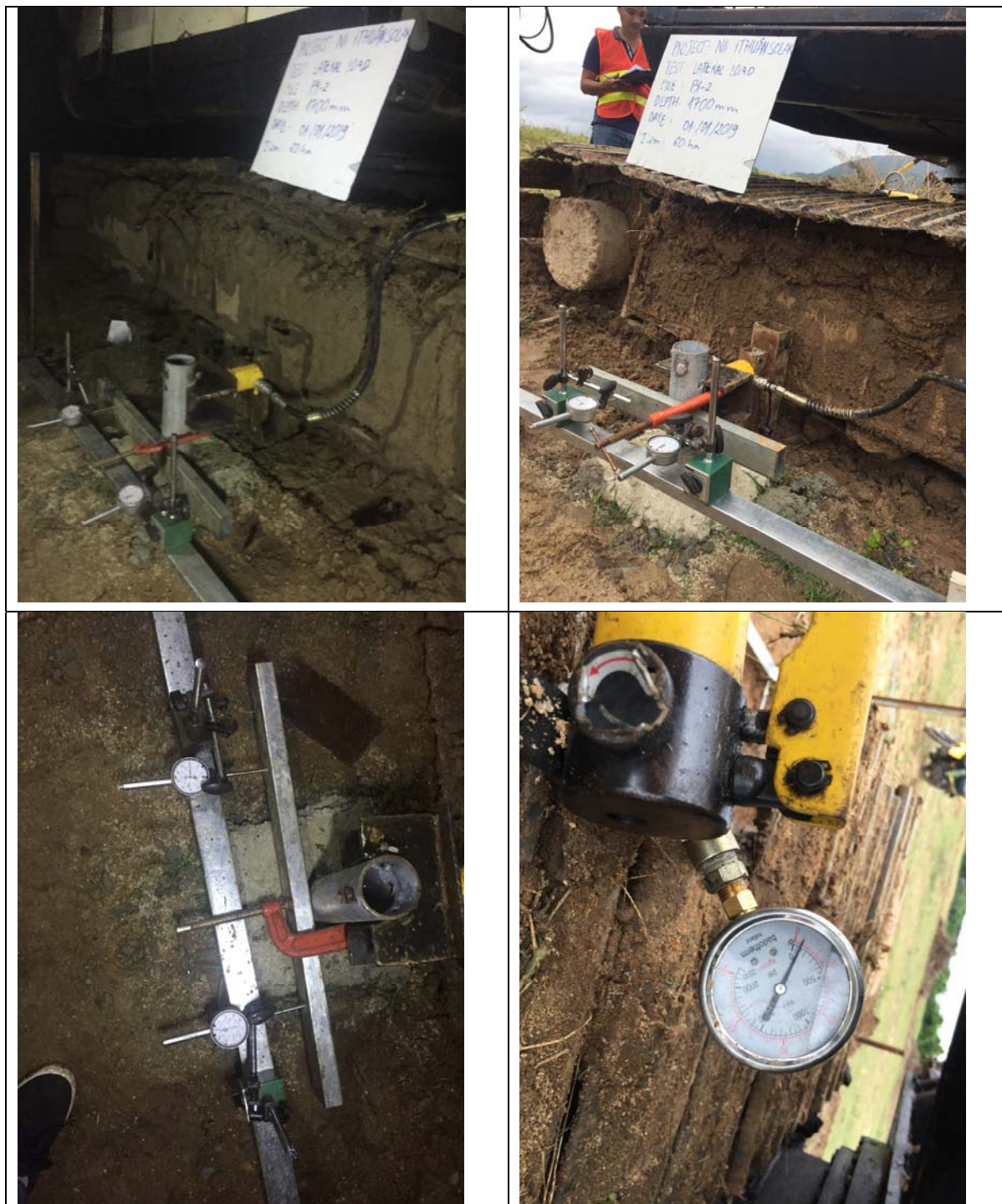
Thí nghiệm cọc đơn dưới tác dụng của tải trọng đẩy ngang Standard test method for deep foundations under lateral load
