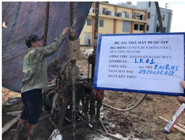
Hình 1. Công tác khoan
